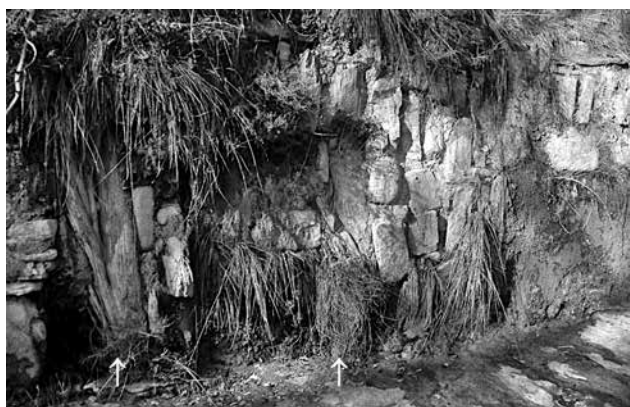
Presa con vigas entre la mampostería
