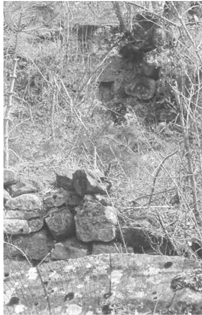
Al fondo: muro de estanque con inicio de saetín Secorún — 2010
