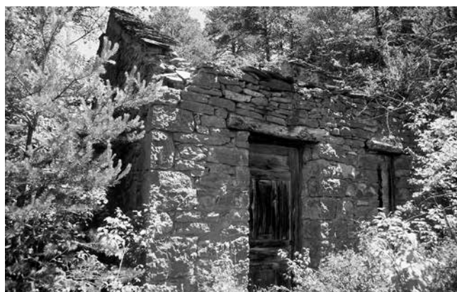
Fachada occidental con entrada
