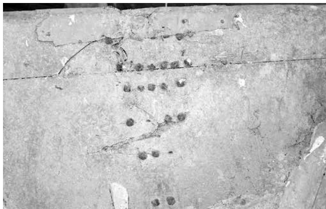
Tolva con filas de clavos que sirven de referencias para el volumen de de grano — 2019
