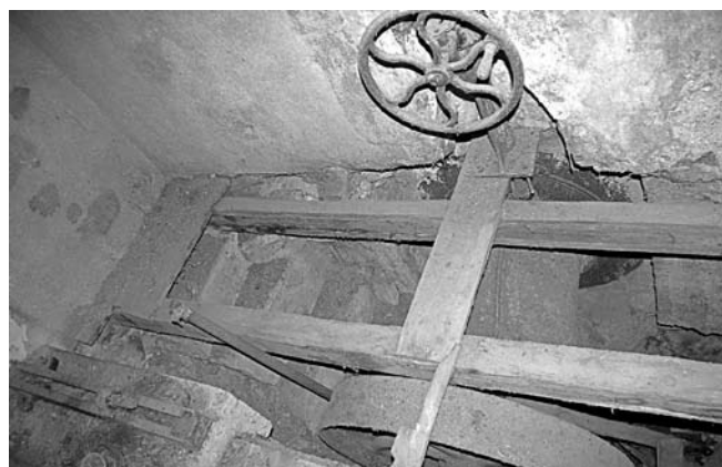
Turbina, polea y rueda que arregla el caudal
