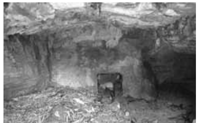
Cárcavo con el saetín bordeado de vigas
