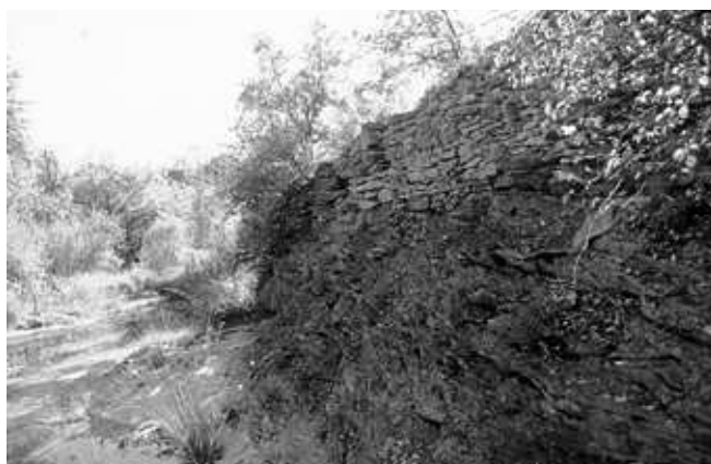
Canal construido sobre la roca
