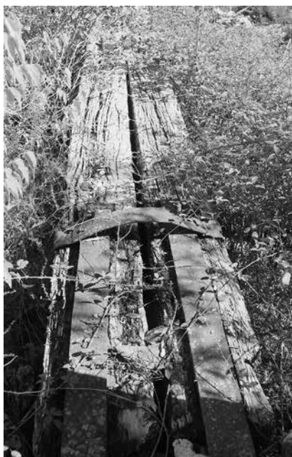
Refuerzo de la viga
