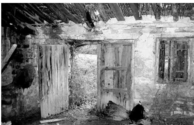
Puerta principal doble de madera
