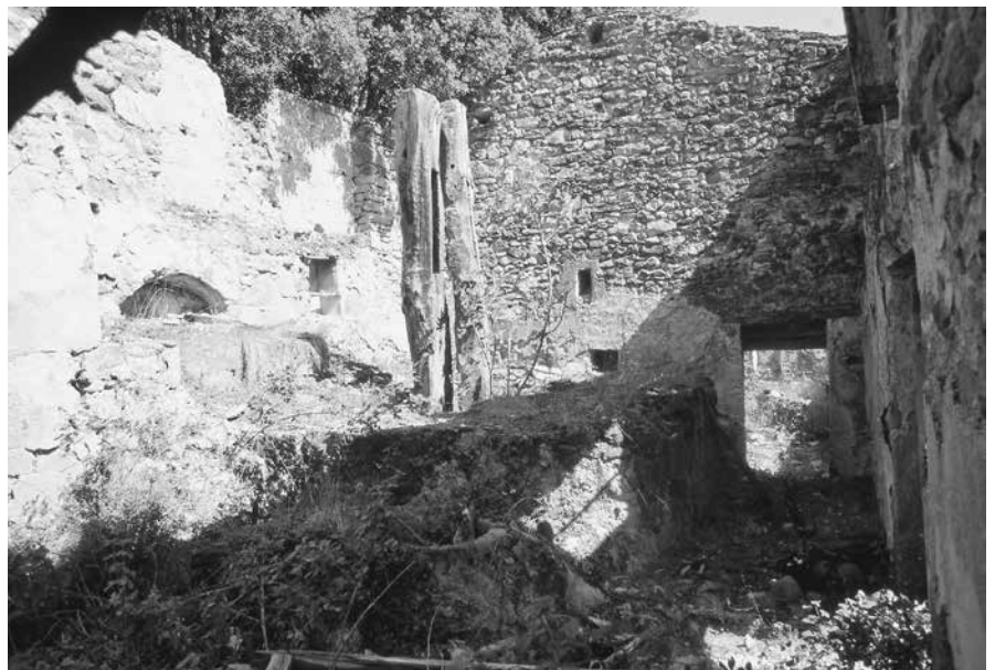
Sala con horno, plataforma de prensa y pilas de piedra. — 6
