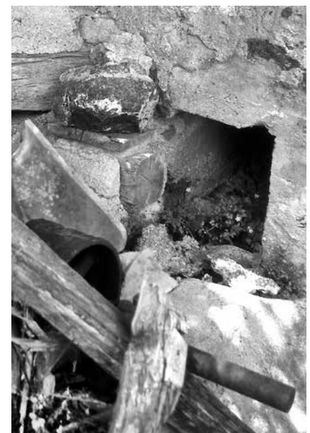
Final exterior del canalón
