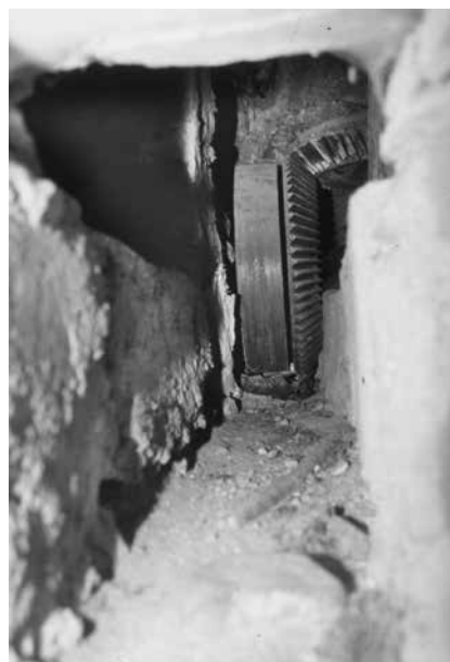
Canalón por debajo de la plataforma
