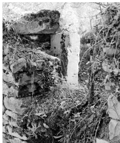
Ventana por encima del cárcavo
