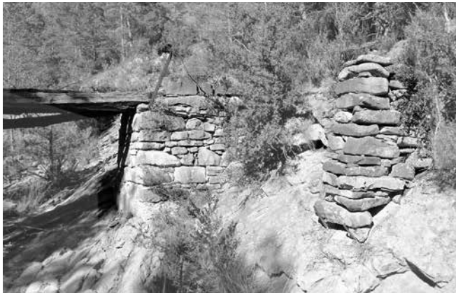
Pequeño muro en la orilla de izquierda, al lado del puente
