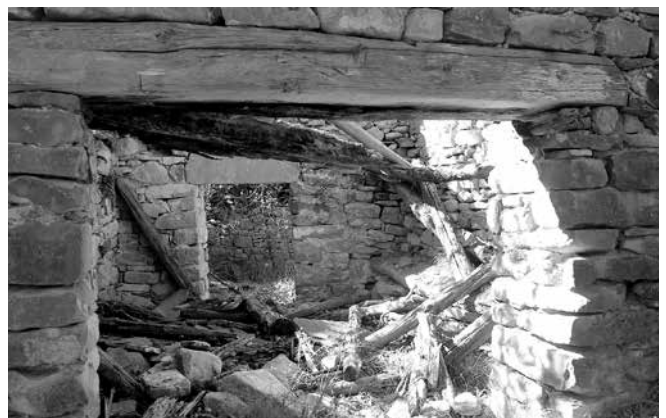
Entrada, antesala y paso hacia la sala de moler
